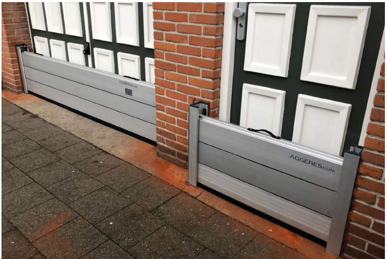
Deuropeningen kunnen bijvoorbeeld met schotbalken relatief eenvoudig dicht worden gezet. (Foto: firma Aggères)
