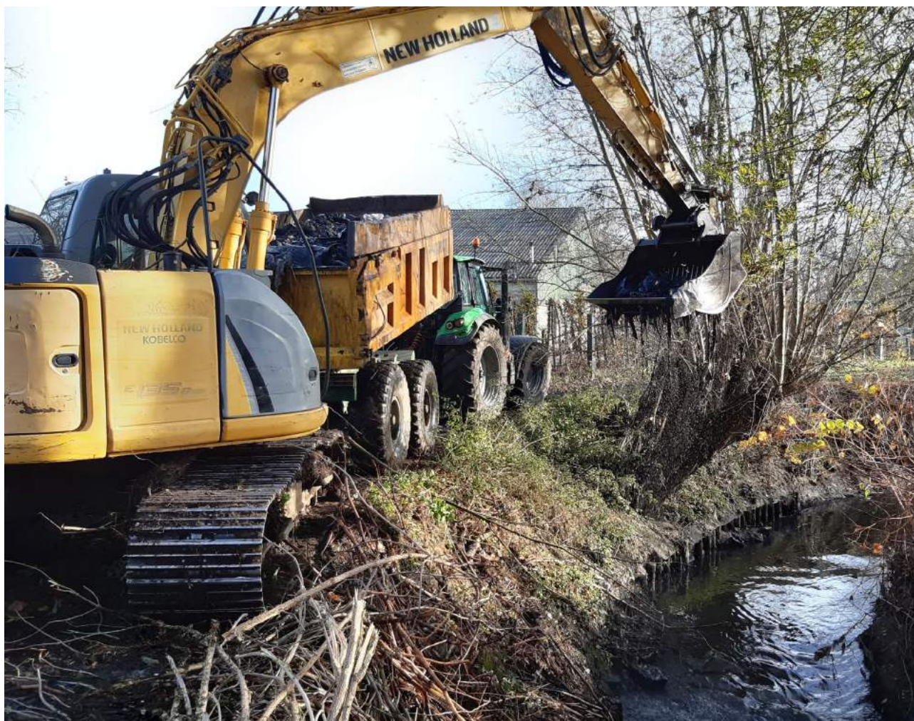
Met een zogenaamde kasseibak op de kraan kan het vele 'gezonken' vuil dat op de bodem ligt worden opgeruimd. Op die manier werd in 2020 over 2 kilometers van de Bellebeek maar liefst 46 ton uitgescheept. (Foto: Hans Nuytens)
