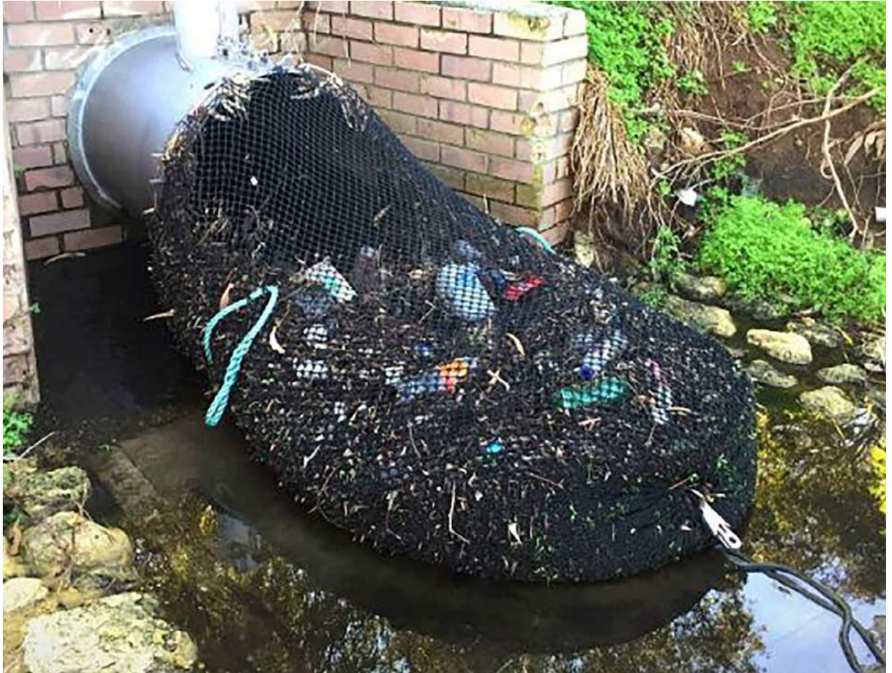
De zogenaamde vuilkous vangt het vuil aan de buizen op. Een voorbeeld dat men in Australië toepast.
