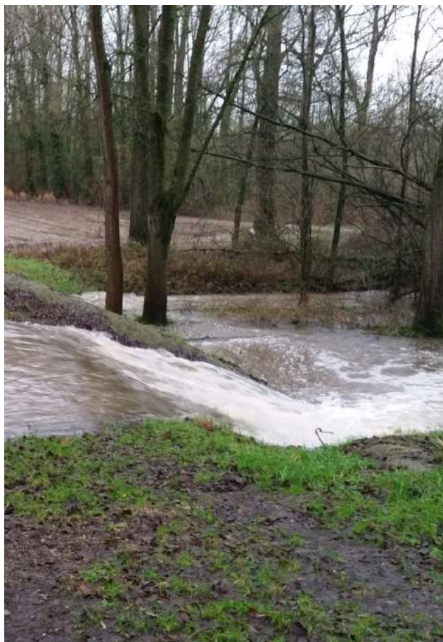
Een GOG is vol en loopt over via een verstevigde verlaging in de dijk. (Foto: Hans Nuytens)
