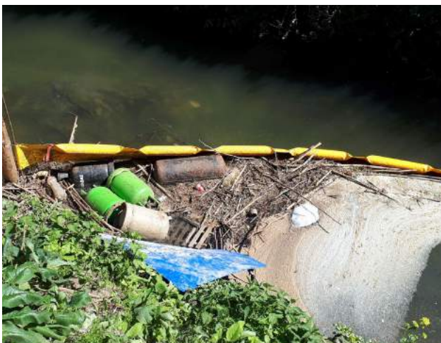
Er is een voorstel om op een aantal strategische plaatsen vuilkeerschermen te plaatsen. (Foto: Ken Van Rooy)
