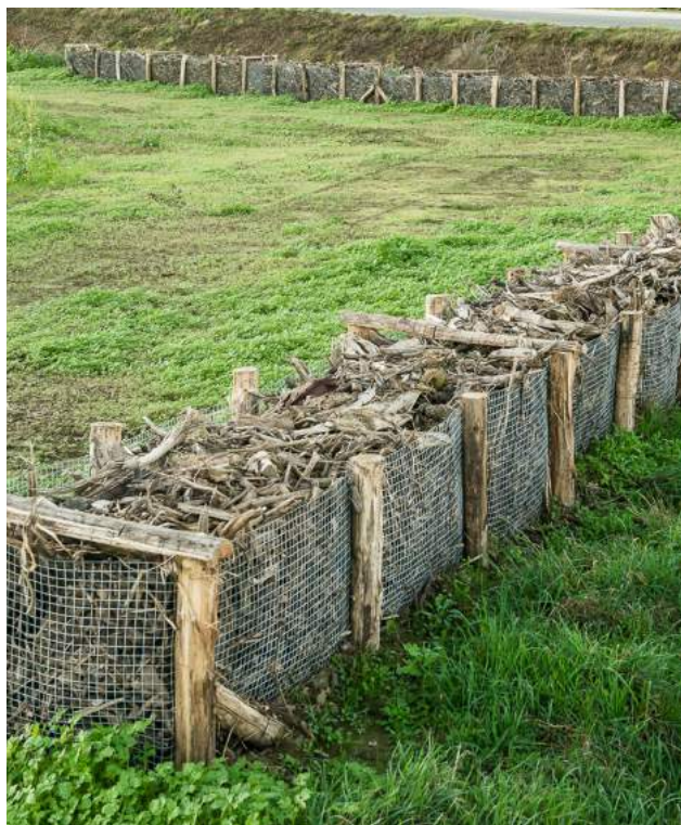
De hakseldam filtert de afstromende bodemdeeltjes uit het water. Een voorbeeld hoe erosie aan de bron wordt aangepakt. (Foto: Provincie Vlaams-Brabant)
