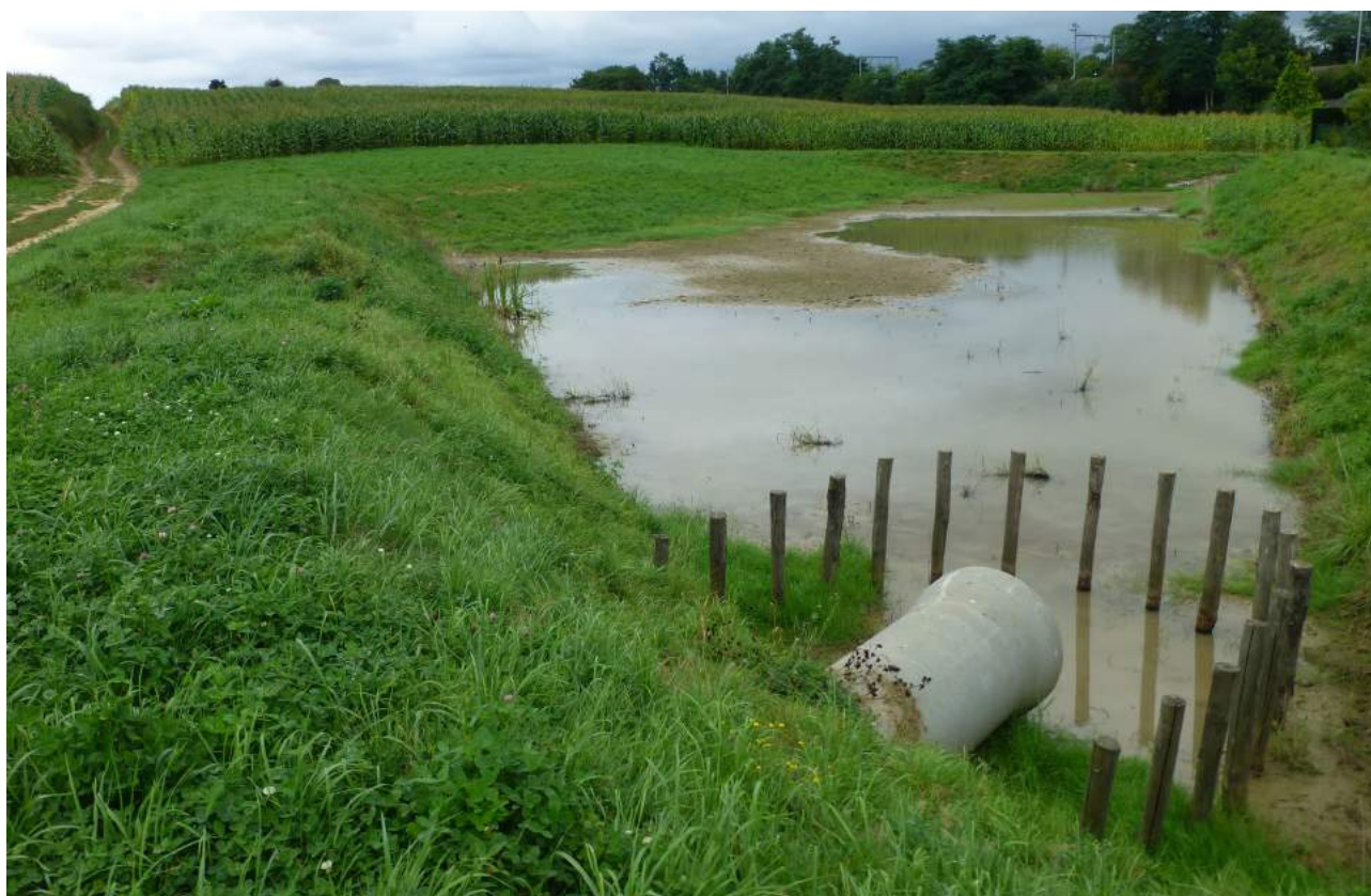
Het water met sediment van de velden wordt in de erosiepoel opgevangen waar het kan bezinken. Is de poel vol, dan loopt het over via de buis naar een gracht. (Foto: Provincie Vlaams-Brabant)
