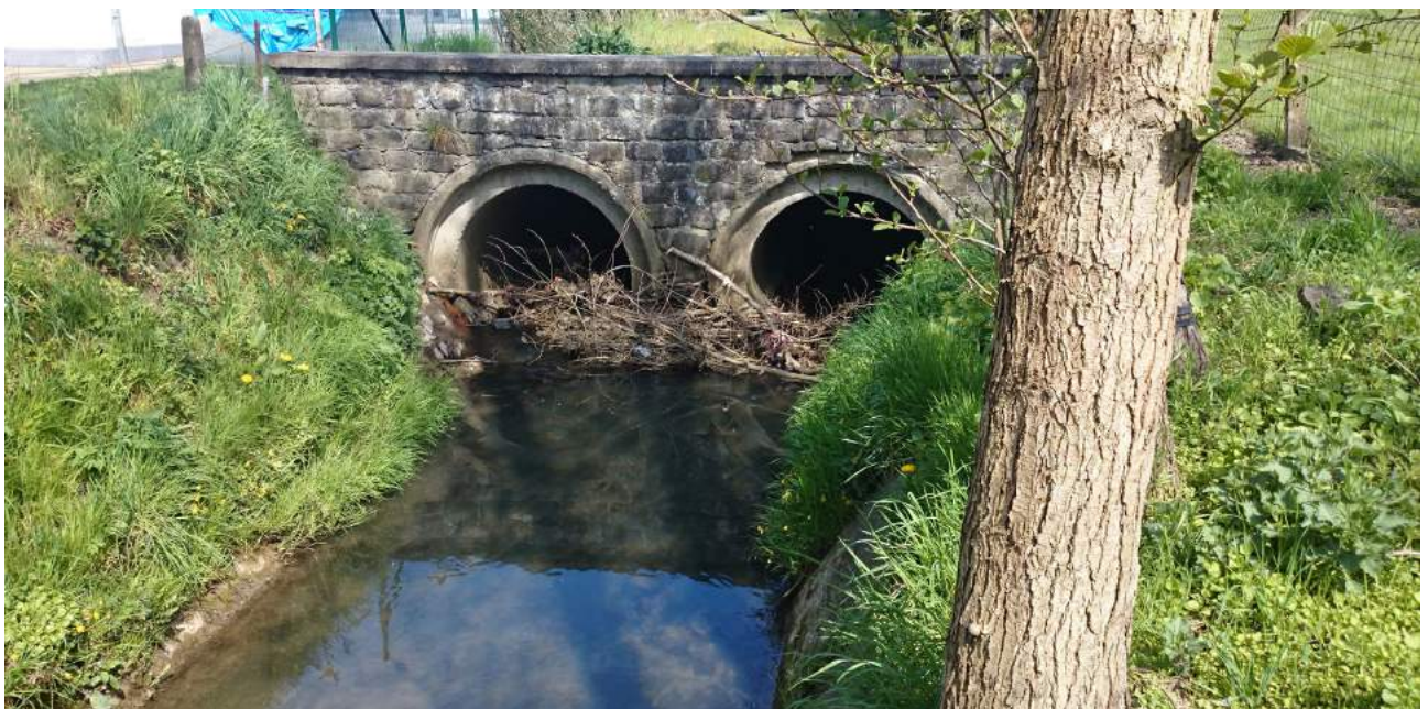
De dubbele kokers zijn erg gevoelig voor obstructies van takken. (Foto: Hans Nuytens)
