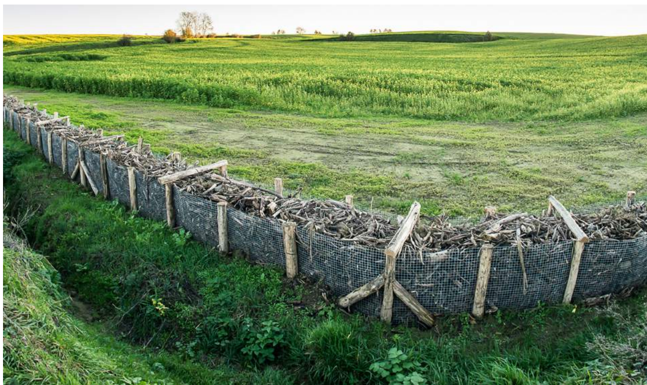
Een houthakseldam is een mogelijke maatregel tegen erosie (Foto: Provincie Vlaams-Brabant)
