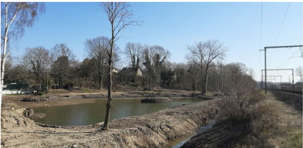
Door de VMM werd de oude spaarvijver van de Neeralfenemolen op de Steenvoordebeek grondig geruimd, de oevers en het eilandje hersteld en nieuwe hengelseigers aangelegd en terug in verbinding gezet met de beek. (Foto: Hans Nuytens)
